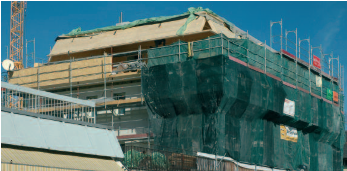
8 L'edificio durante la riqualificazione.
