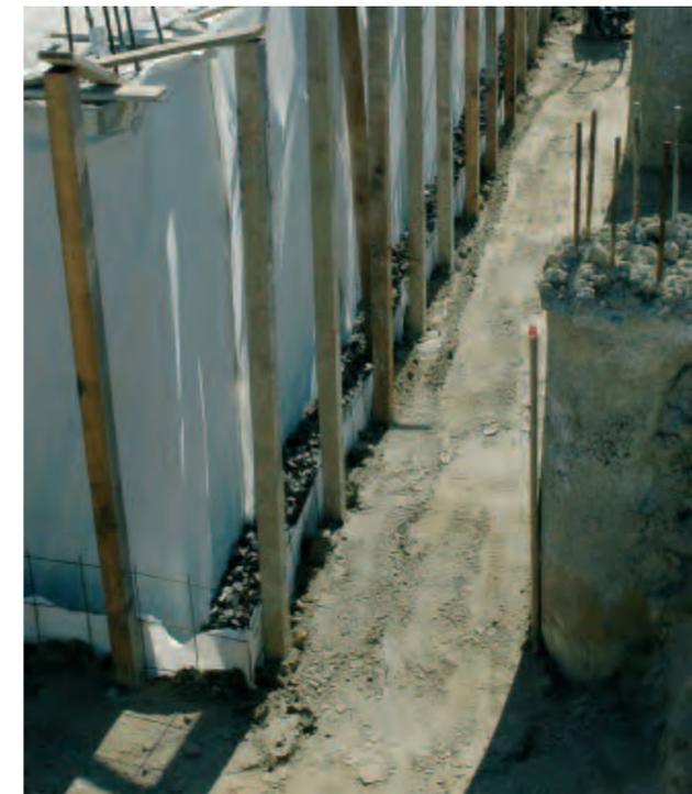
I pilastri, in funzione della natura del carico e delle proprietà del suolo, possono avere caratteristiche diverse. Se si eleva l'armatura fino al plinto di fondazione vi sono svantaggi a livello termico.
